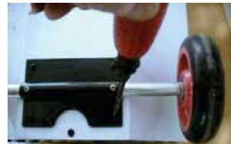
Passer les roues dans l'axe et bloquer les écrous / Fixer l'ensemble sur la base de l'appareil.
